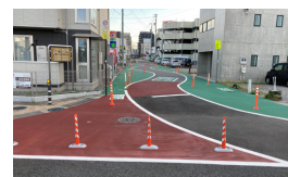
長野市長野駅東口 スピードを出しすぎないように、車道を曲線に
