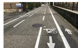
金沢市尾張町 車道が狭くなっても歩道と自転車レーンを確保
